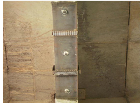
Fig. 10. End anchor
